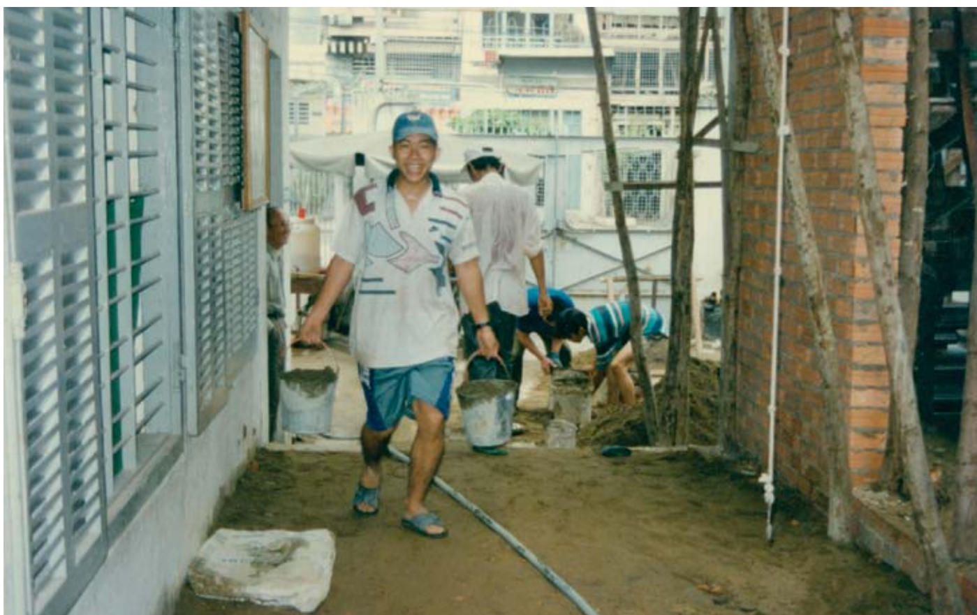
DÂNG CÔNG SỬA CHỮA & DỌN DỆP NHÀ THỜ 1998
