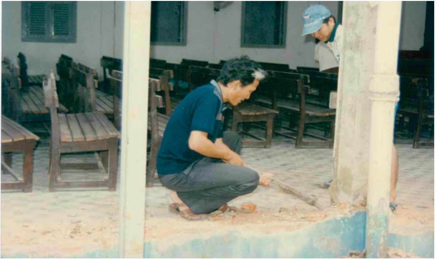
DÂNG CÔNG SỬA CHỮA & DỌN DỆP NHÀ THỜ 1998
