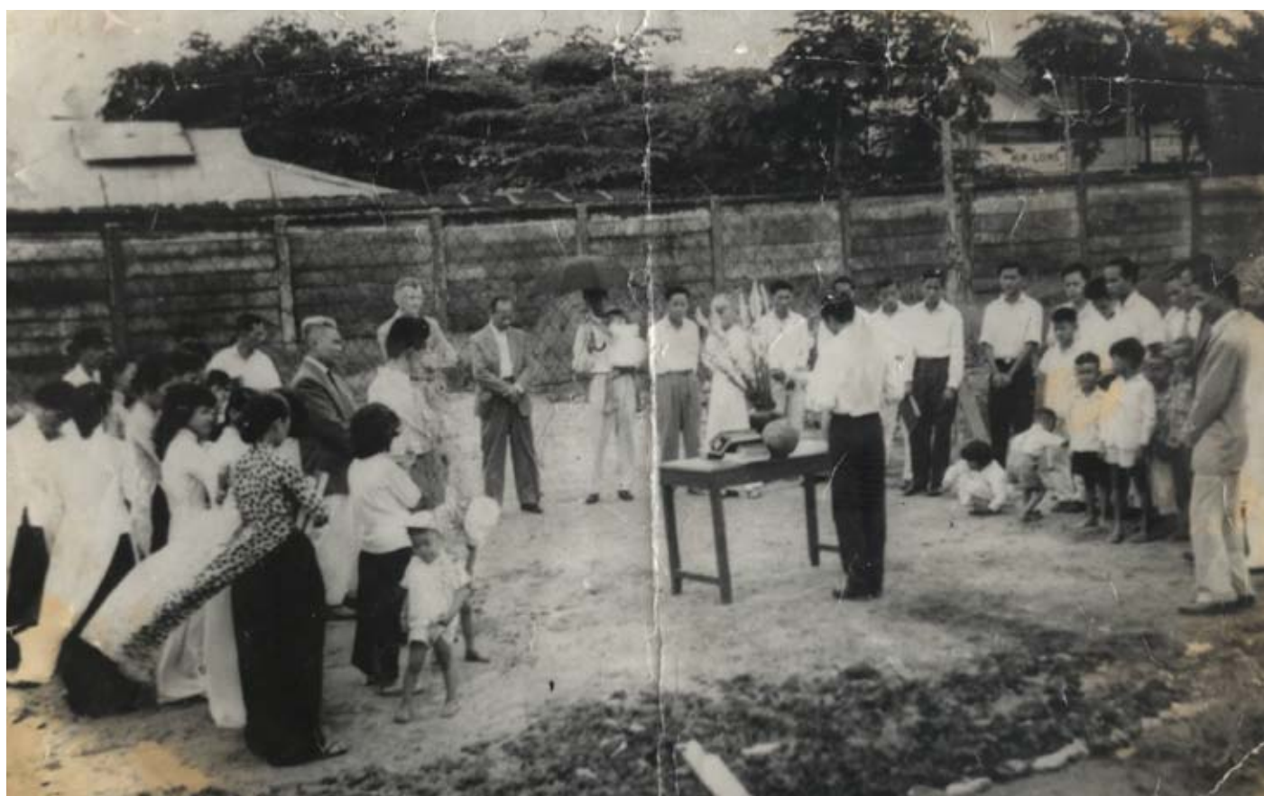
LỄ KHỞI CÔNG XÂY CẤT NHÀ THỜ KHÁNH HỘI
