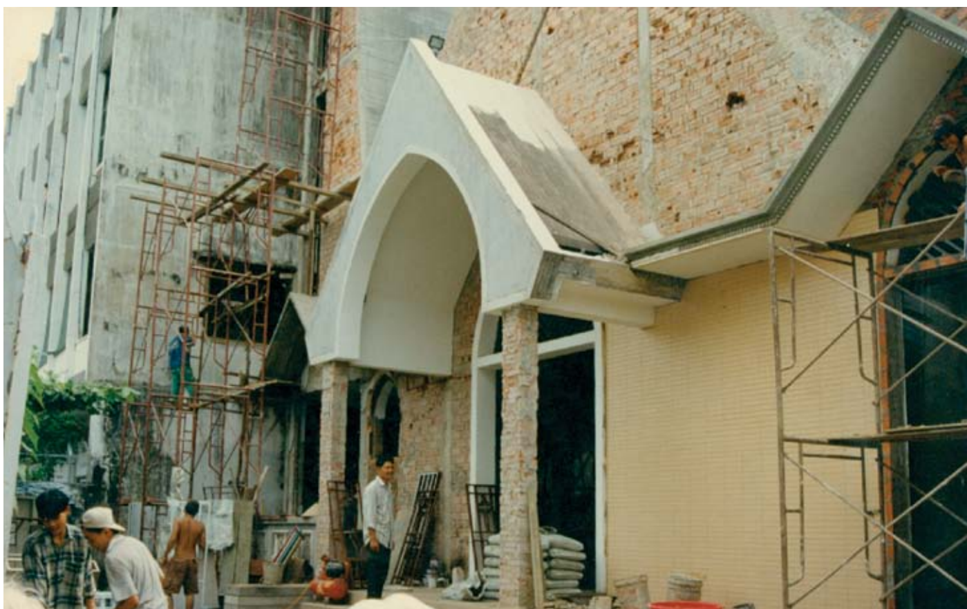
SỬA CHỮA NỞI RỘNG NHÀ THỜ 1998
