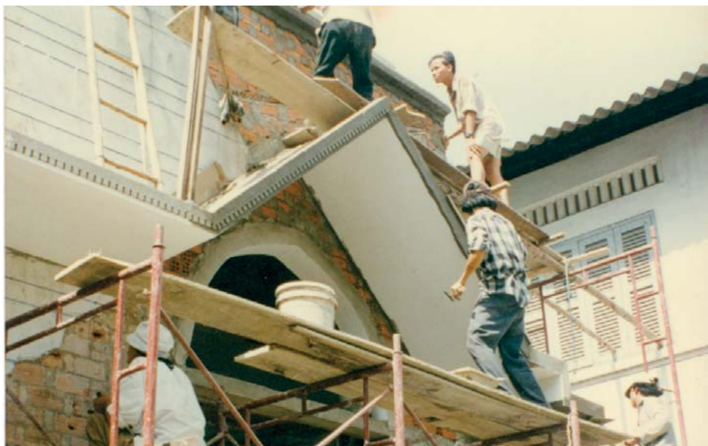
SỬA CHỮA NỞ RỘNG 2 BÊN HÔNG NHÀ THỜ 1998
