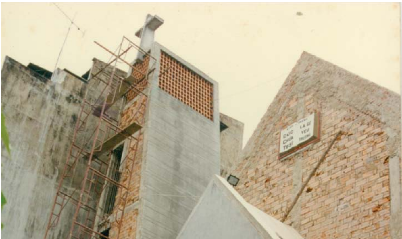
SỬA CHỮA NỞI RỘNG NHÀ THỜ 1998
